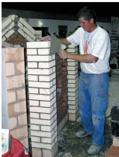
Das anspruchsvolle Bauwerk im Werden.
